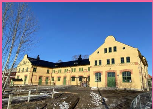
Stora stallet i Hågelbyparken är färdigrenoverat.
